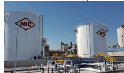
909タンク 908タンク
