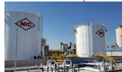
909タンク 908タンク
